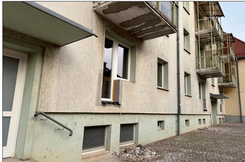
Die Betonsanierung der alten Balkone ist bereits erfolgt, die Fensterbrüstungen der 4 Erdgeschosswohnungen wurden herausgeschnitten und die neuen Balkontürelemente wurden eingebaut. Die Werkplanung für die neuen Balkone liegt uns, aufgrund von Planungsgängen leider noch
