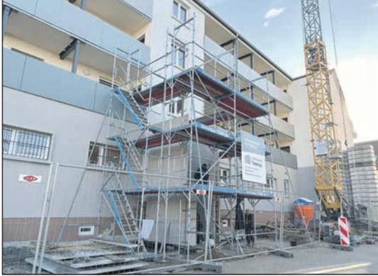
Nun kann der Schacht Stück für Stück nach oben gezogen werden, bevor die Aufzugsanlage dann in 2024 eingebaut wird.
