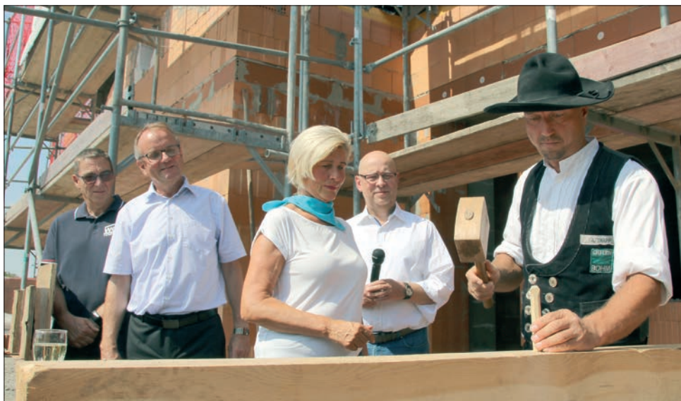
Mit dem Setzen der Richtkrone ist ein wichtiger Bauabschnitt abgeschlossen worden.
